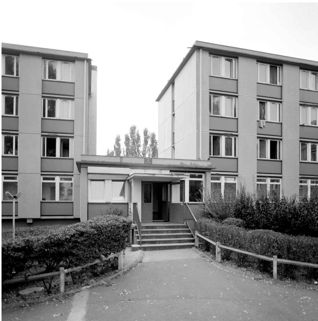
Vue de l'entrée, au centre des ailes nord et sud.
