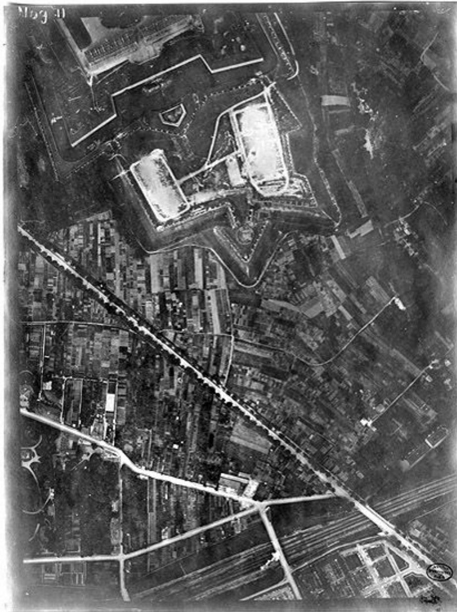
Vue aérienne du quartier du fort. Tirage photographique, circa 1925. Tiré de : Nogent-sur-Marne : étude de l'évolution d'une commune de banlieue. Thèse d'urbanisme, université d'urbanisme de Paris / Maurice Salabert, 1928. (Musée Nogent-sur-Marne)
