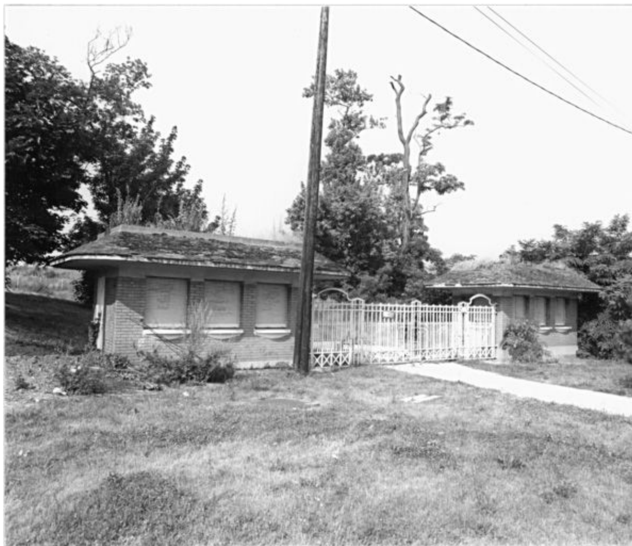
Façades antérieures des guichets d'entrée.
