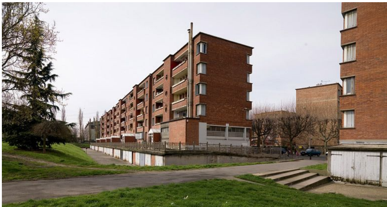
Alfortville, cité HBM du square St- Pierre, rue de Grenoble, rue de Dijon, rue de Genève. Vue d'une des barres
