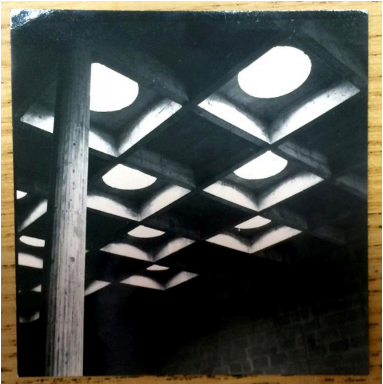
Vue du couvrement du bâtiment de service durant le chantier, circa 1954. SIAF/CAPA. Fonds Robert Auzelle 242 IFA, boîte 50, affaire RA 09.
