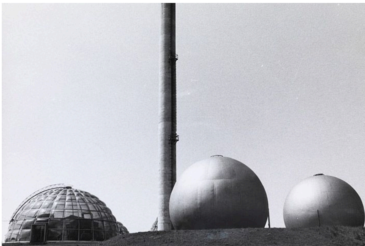
Chaufferie de Meaux. (Cité de l'architecture et du patrimoine. fonds DAU 173/1)
