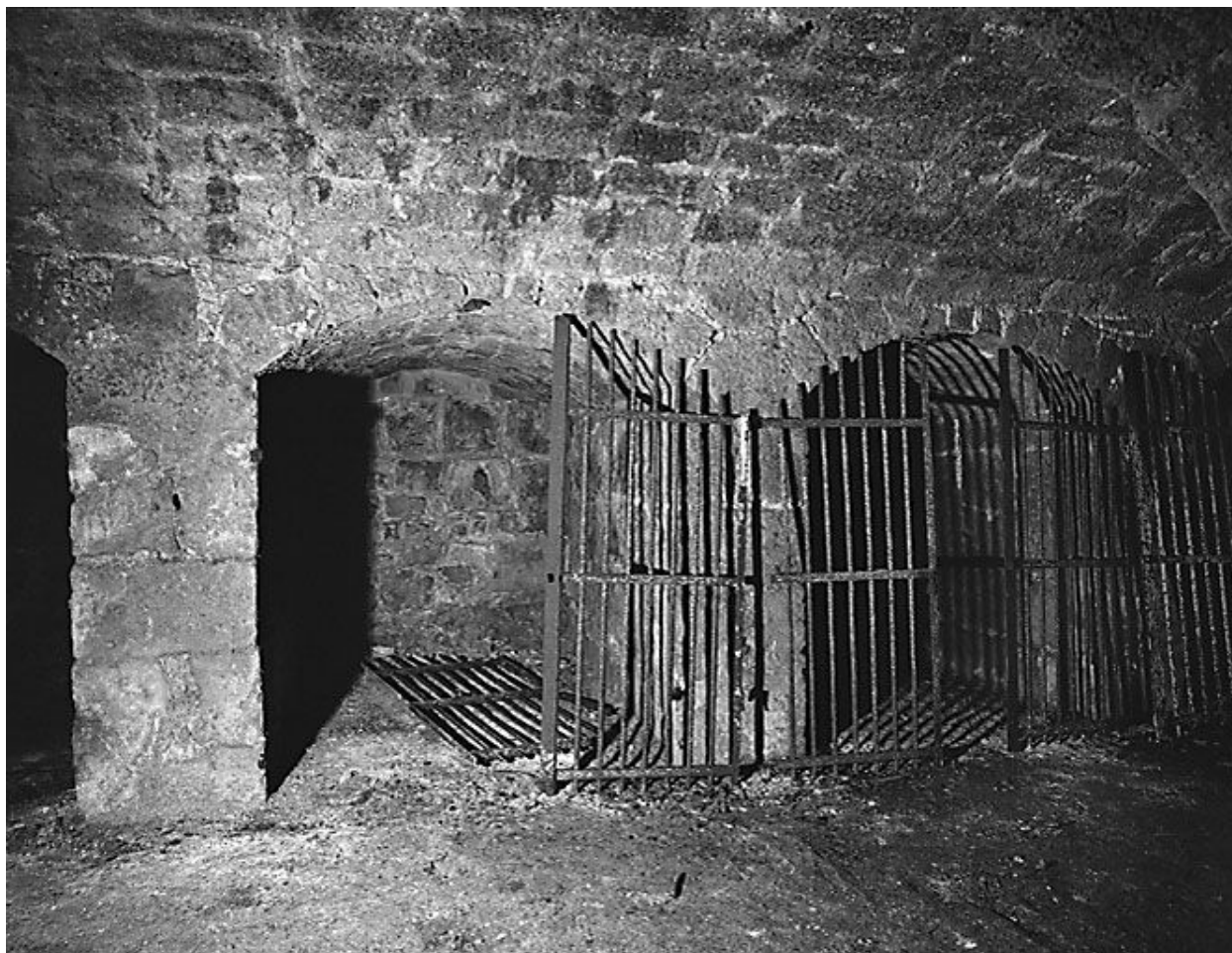
Deuxième niveau de cave : les niches latérales, vues de côté.
