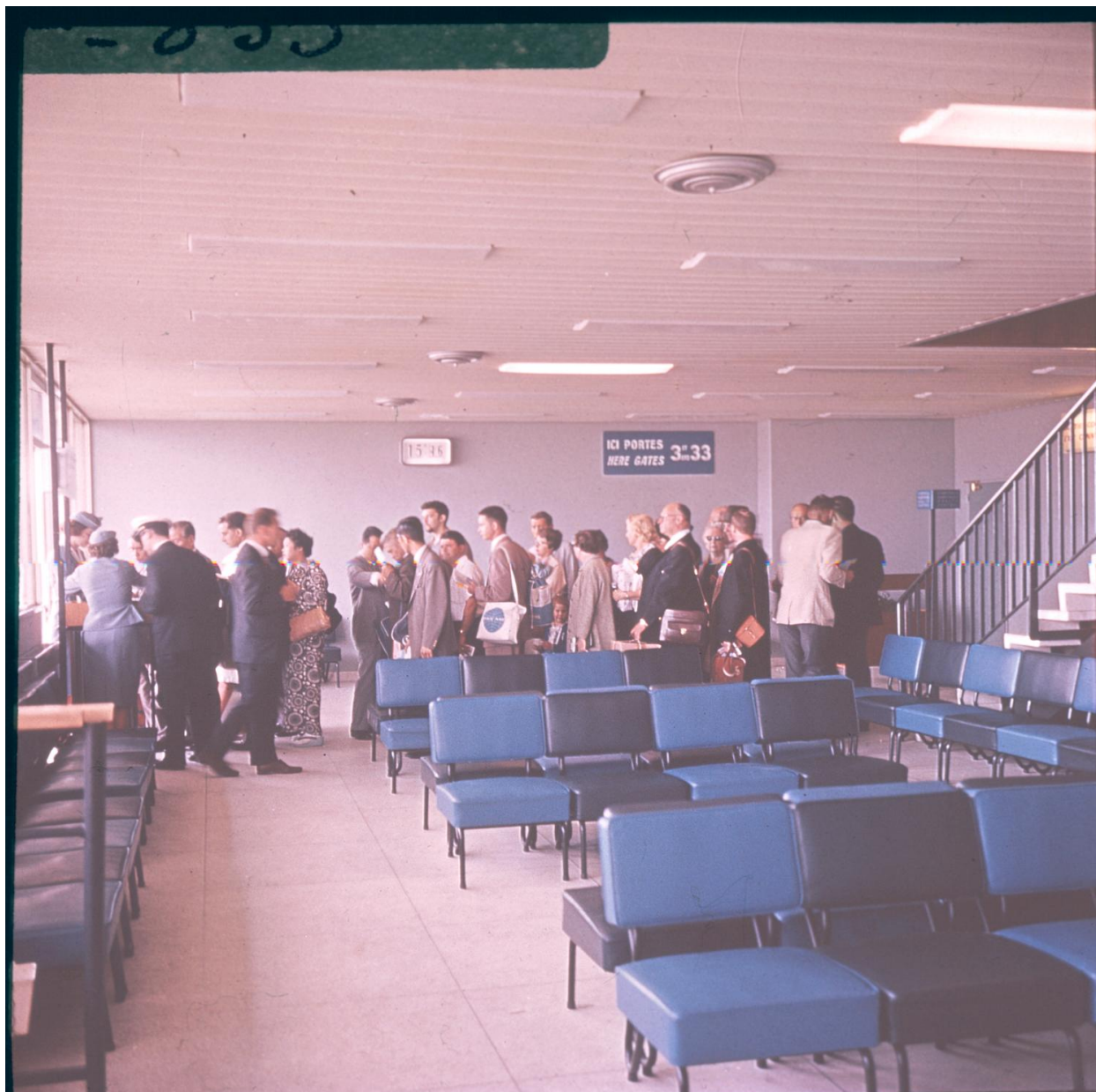
1961, salle d'embarquement, rez-de-chaussée coté piste.
