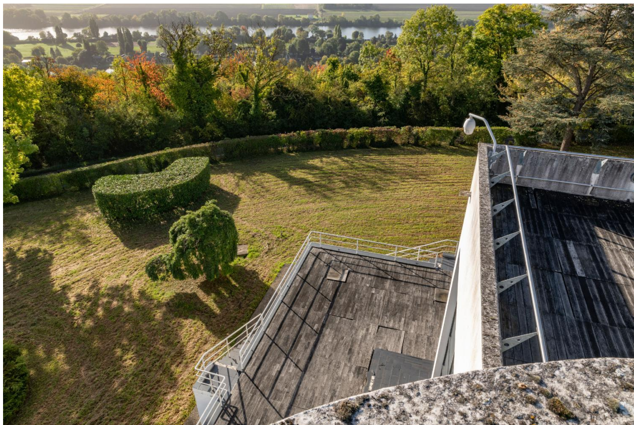
Villa Poiret, vue depuis les terrasses
