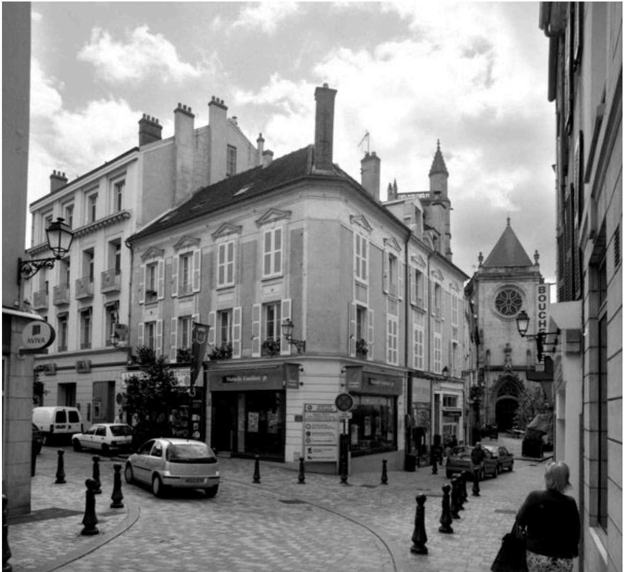
Vue d'ensemble, depuis la rue Carnot.
