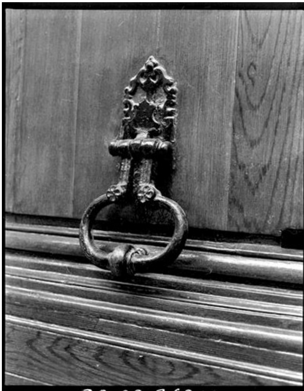
Maison, Sangle (rue de la) 25. Détail du heurtoir.
