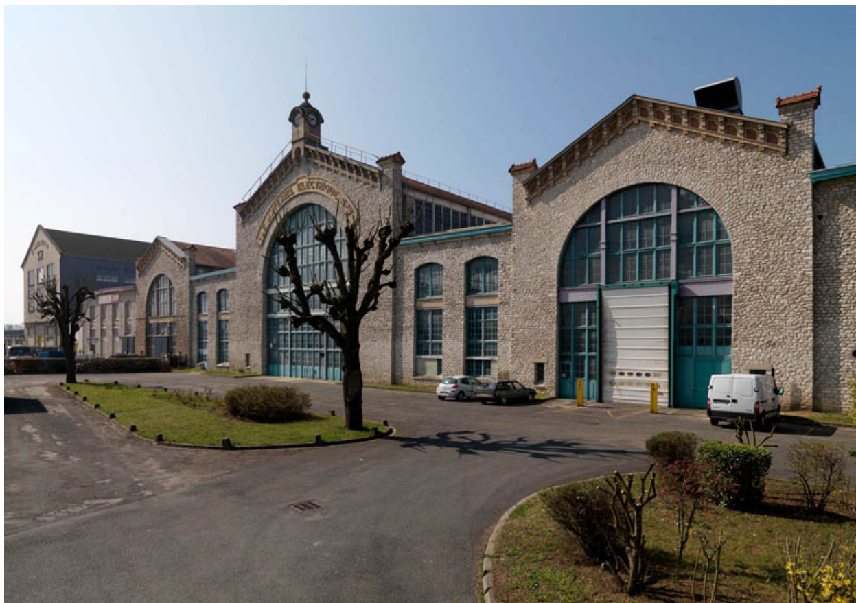
Vue extérieure de l'usine côté voie ferrée. la nef centrale et la liaison longitudinale nord.
