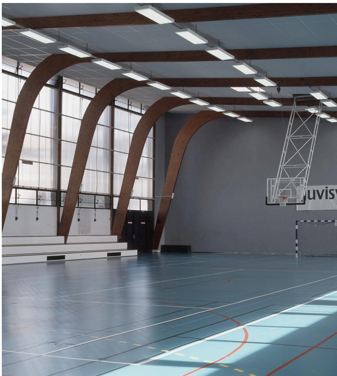
Vue des structures intérieures de bois lamellé-collé du gymnase.
