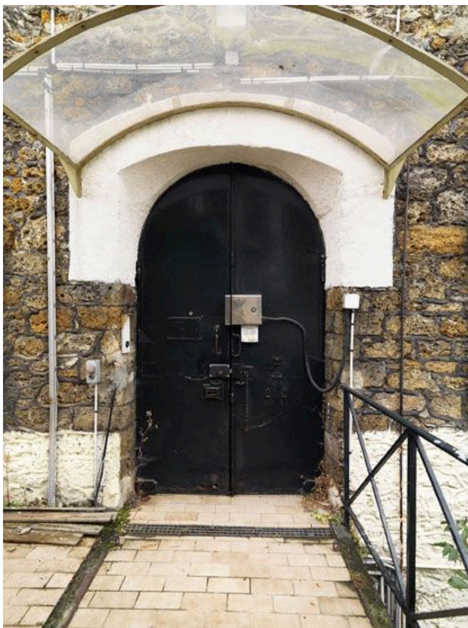
Le portail de l'enceinte de la maison d'arrêt, vu depuis l'intérieur.
