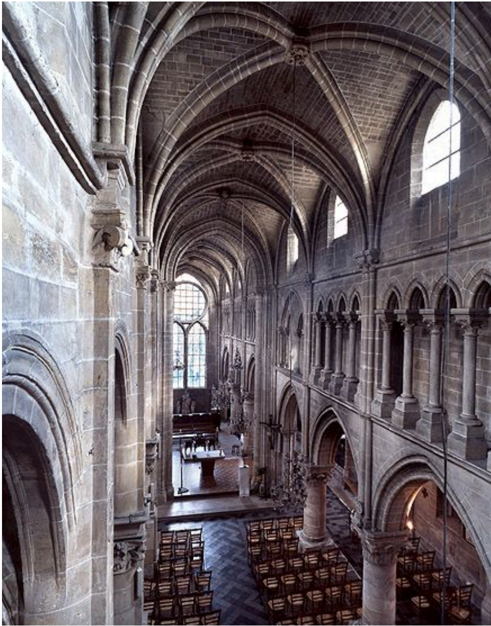
Vue d'ensemble depuis la tribune de l'orgue. On remarquera le désaxement du chœur.
