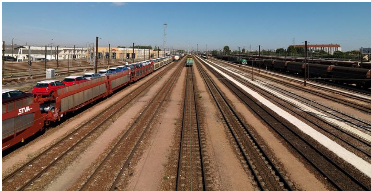
Villeneuve-Saint-Georges. Vue des voies depuis la passerelle piétonne., à gauche les ateliers.
