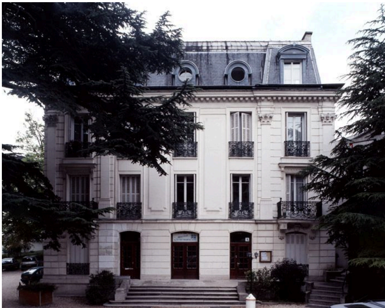
Demeure accueillant aujourd'hui un institut biblique, 39 Grande rue Charles de Gaulle. Vue d'ensemble de la façade sur la rue.
