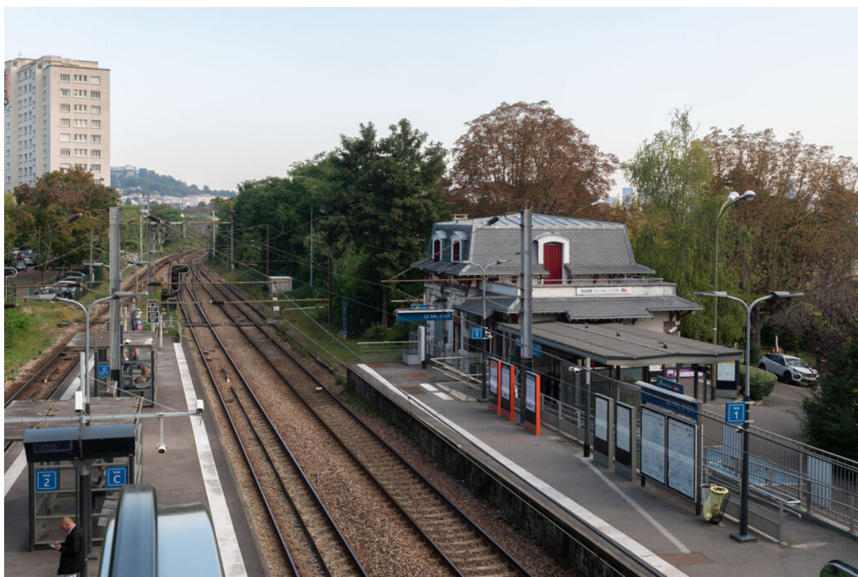
Gare du Val d'Or, vue depuis la passerelle des voyageurs
