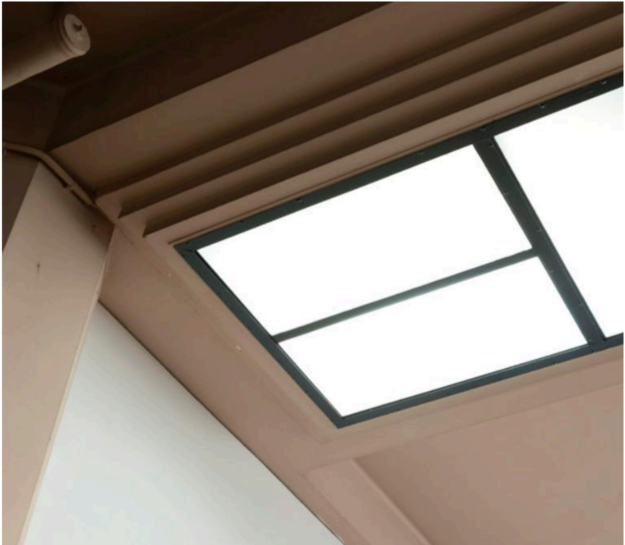
L'éclairage zénithal de la cage d'escalier.
