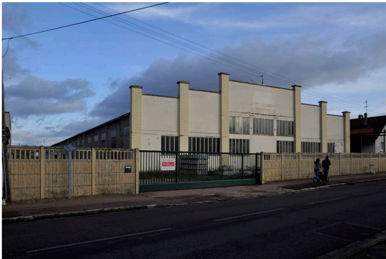
Aubergenville, vue de l'ancienne usine d'éléments préfabriqués (éléments en ferro-ciment) Grondel Frères.
