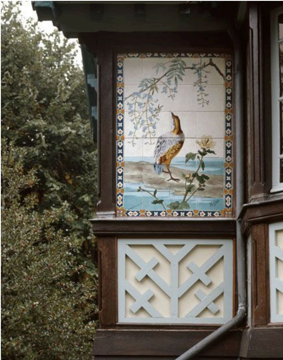
La façade nord est du pavillon chinois : détail des céramiques encadrant l'ancienne porte d'entrée.
