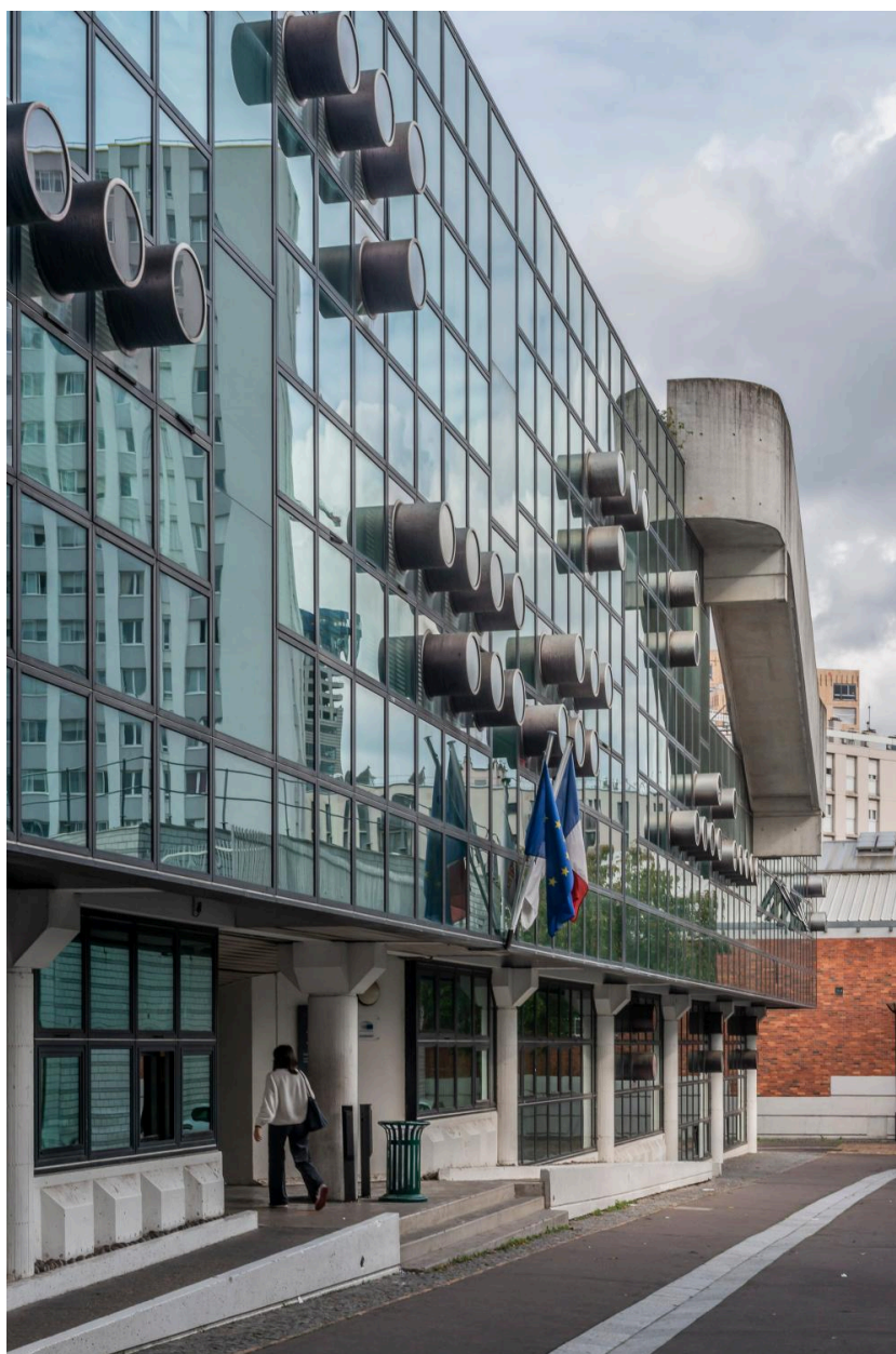
La façade côté rue intérieure et l'entrée de l'établissement.
