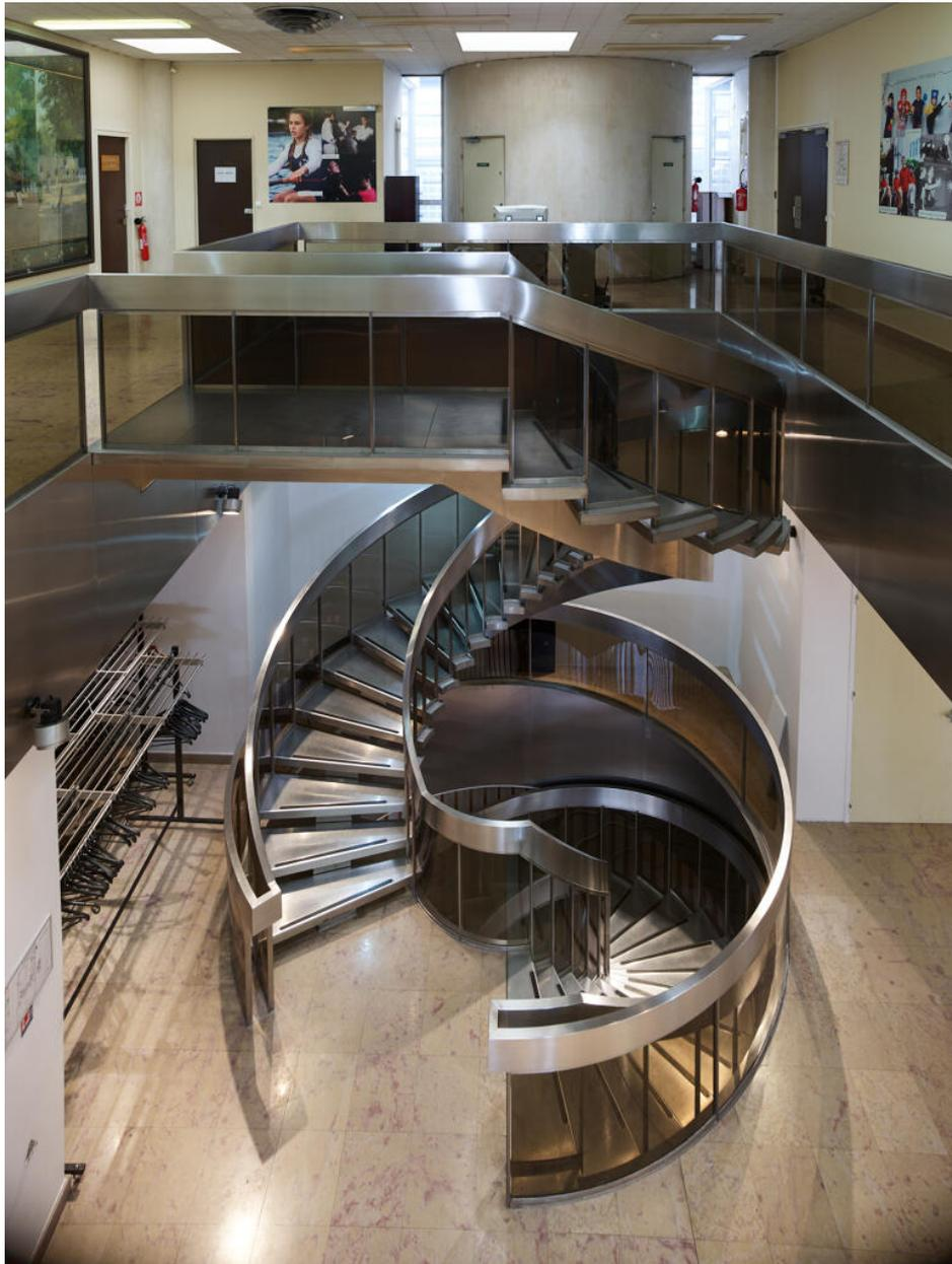
Vue de l'escalier en vis desservant les bureaux du deuxième étage. Limon, rampes et marches en acier inoxydable, garde-corps en verre fumé. Conçu par G. Picquenard, construit par l'entreprise Voisin (fabrication en atelier, puis remonté sur place).
