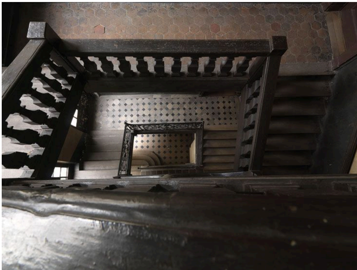
Vue en contreplongée du vide central, 22, rue Geoffroy-l'Asnier.
