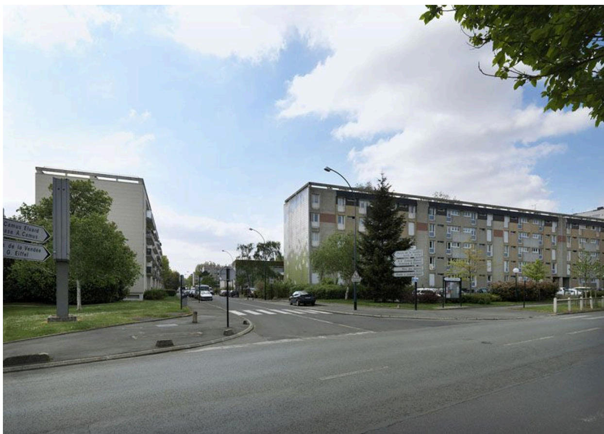
Vue générale des barres de l'opération Robert.
