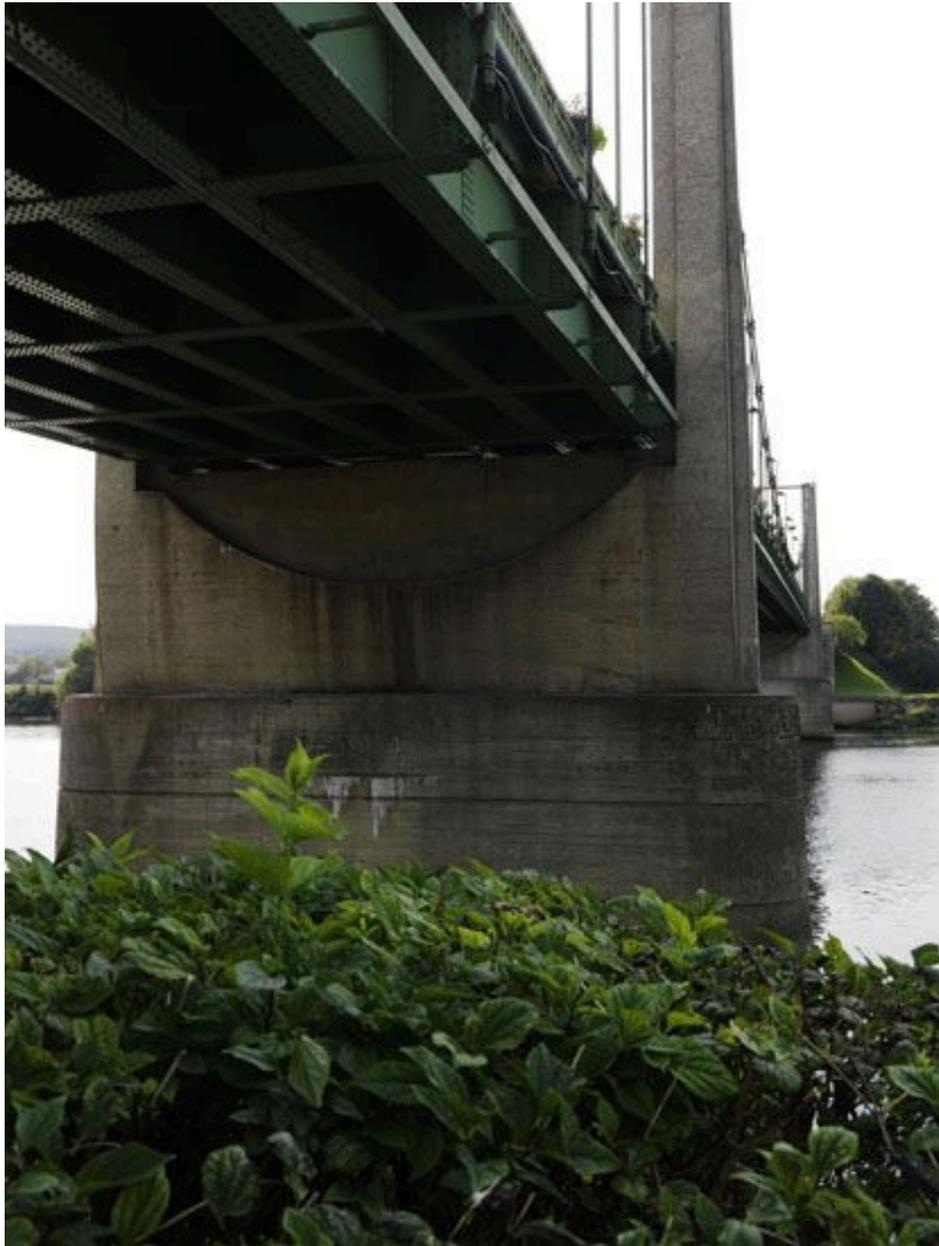
Tablier du pont et ses poutres métalliques vus depuis les quais vers l'amont. On aperçoit la première pile en béton et la naissance d'une tige verticale de suspension.
