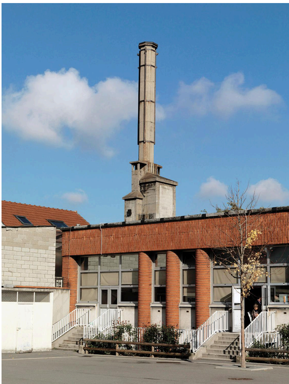
Vue de la cheminée de la chaudière.
