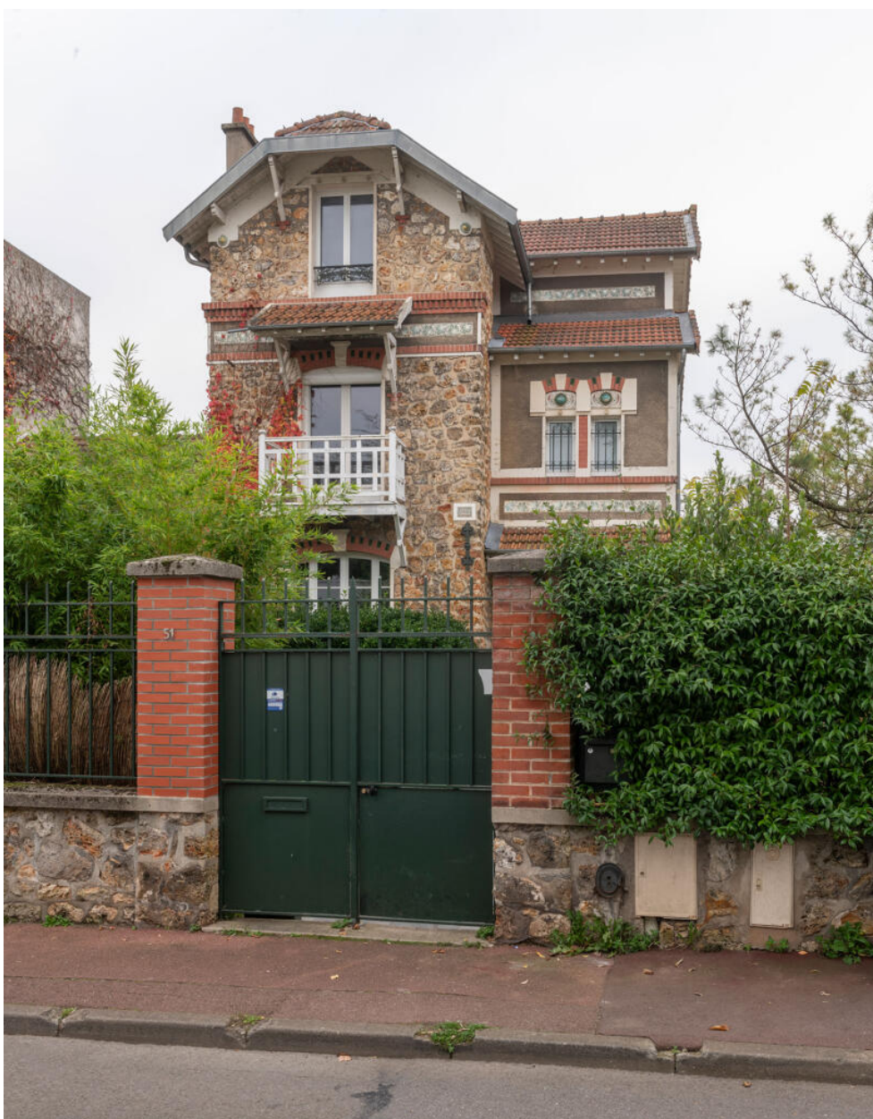
Maison d'habitation, façade principale.
