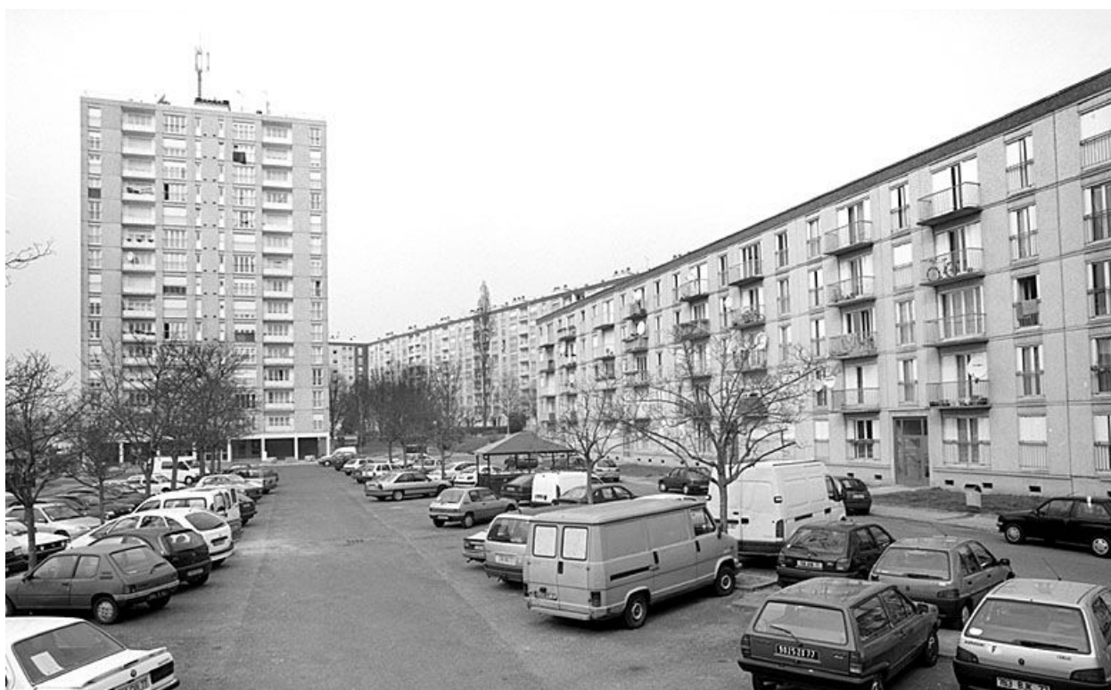
Tour de Lorient (13 square de Lorient, 1963-1964) et barres de l'unité résidentielle de Montaigu (14-24 square de Lorient), vues depuis l'est.
