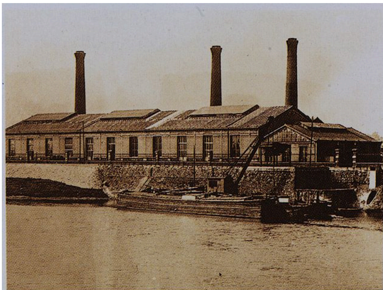
L'usine d'Ivry au début du siècle, vue depuis la Seine.
