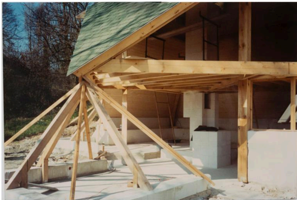
Vue du chantier.
