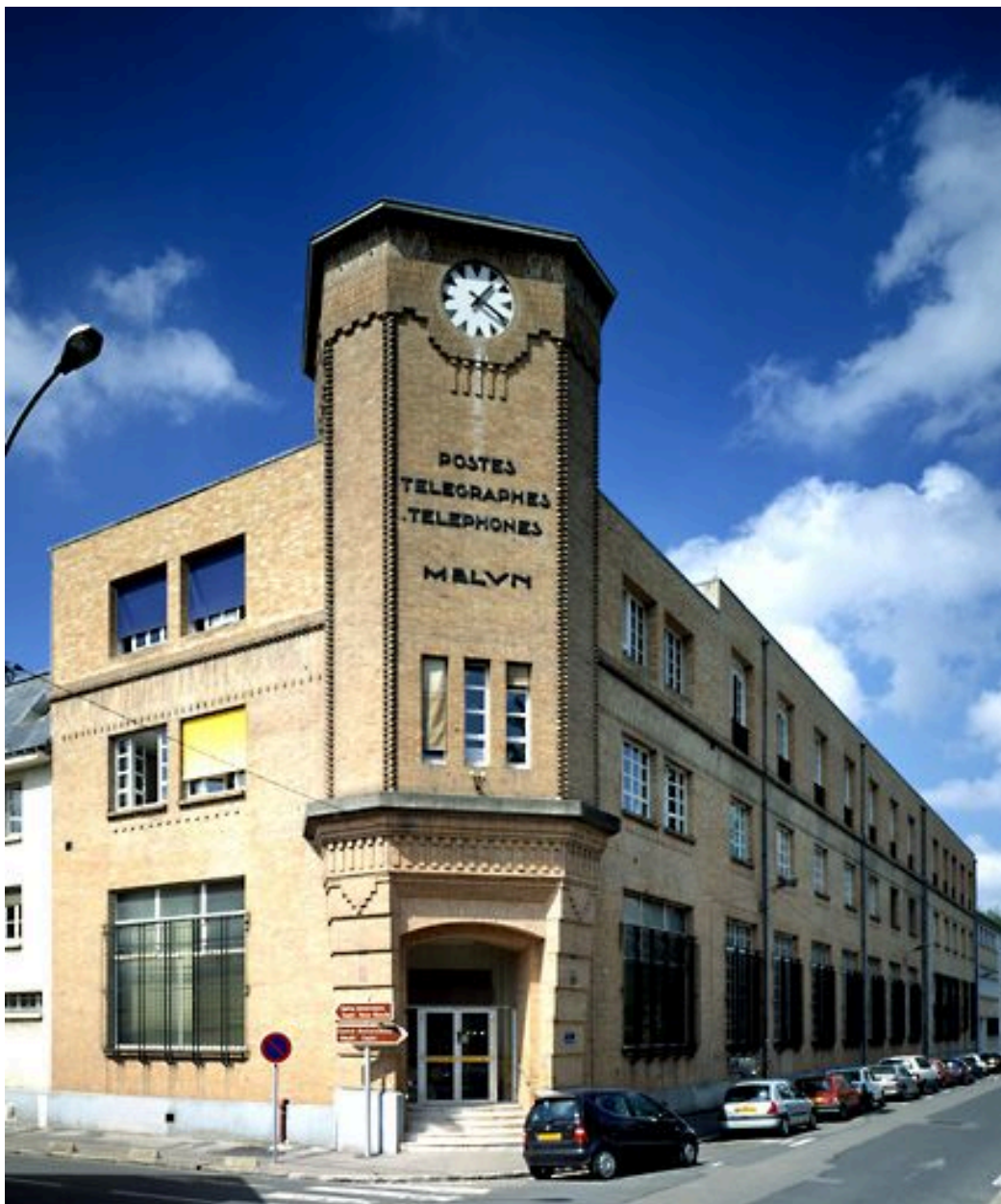
Vue générale, depuis l'est.
