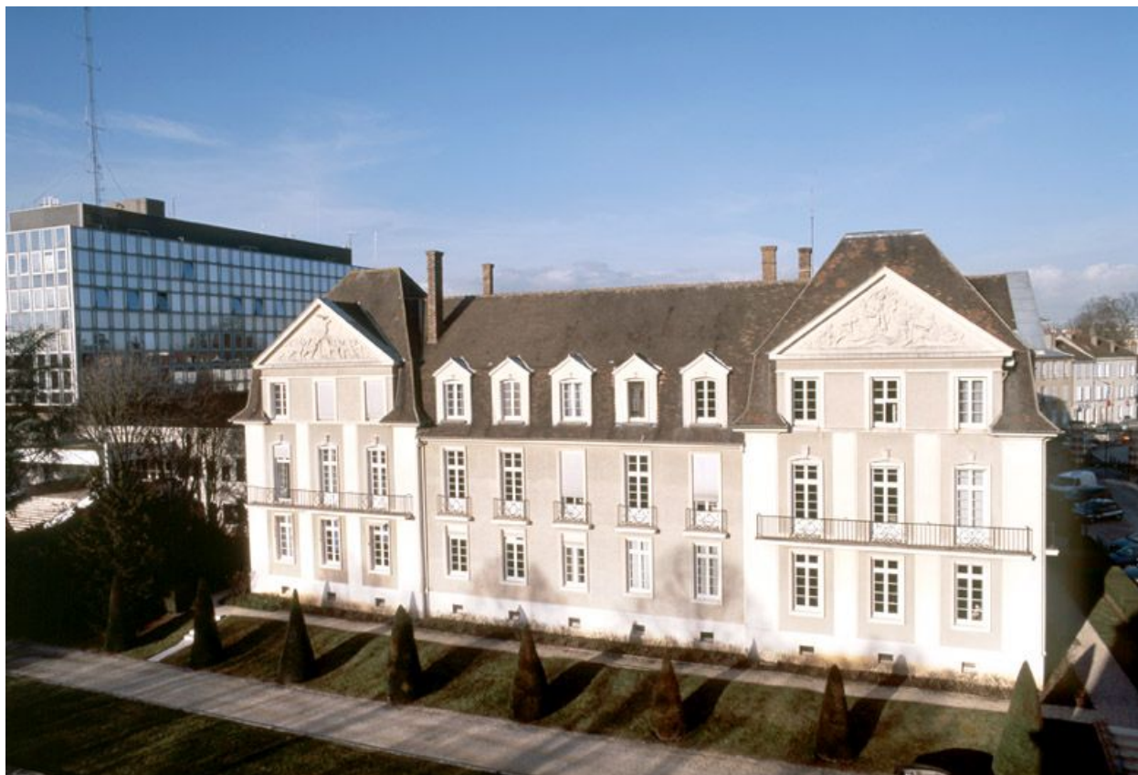
Le bâtiment des années 1950, vu depuis l'hôtel de la préfecture.
