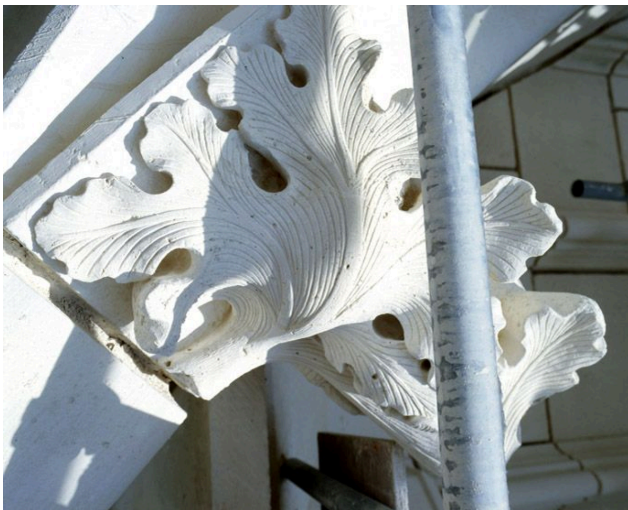
La façade occidentale : vue du chantier de restauration de la base de la tour nord (2008). Détail de la restauration d'un chou frisé.
