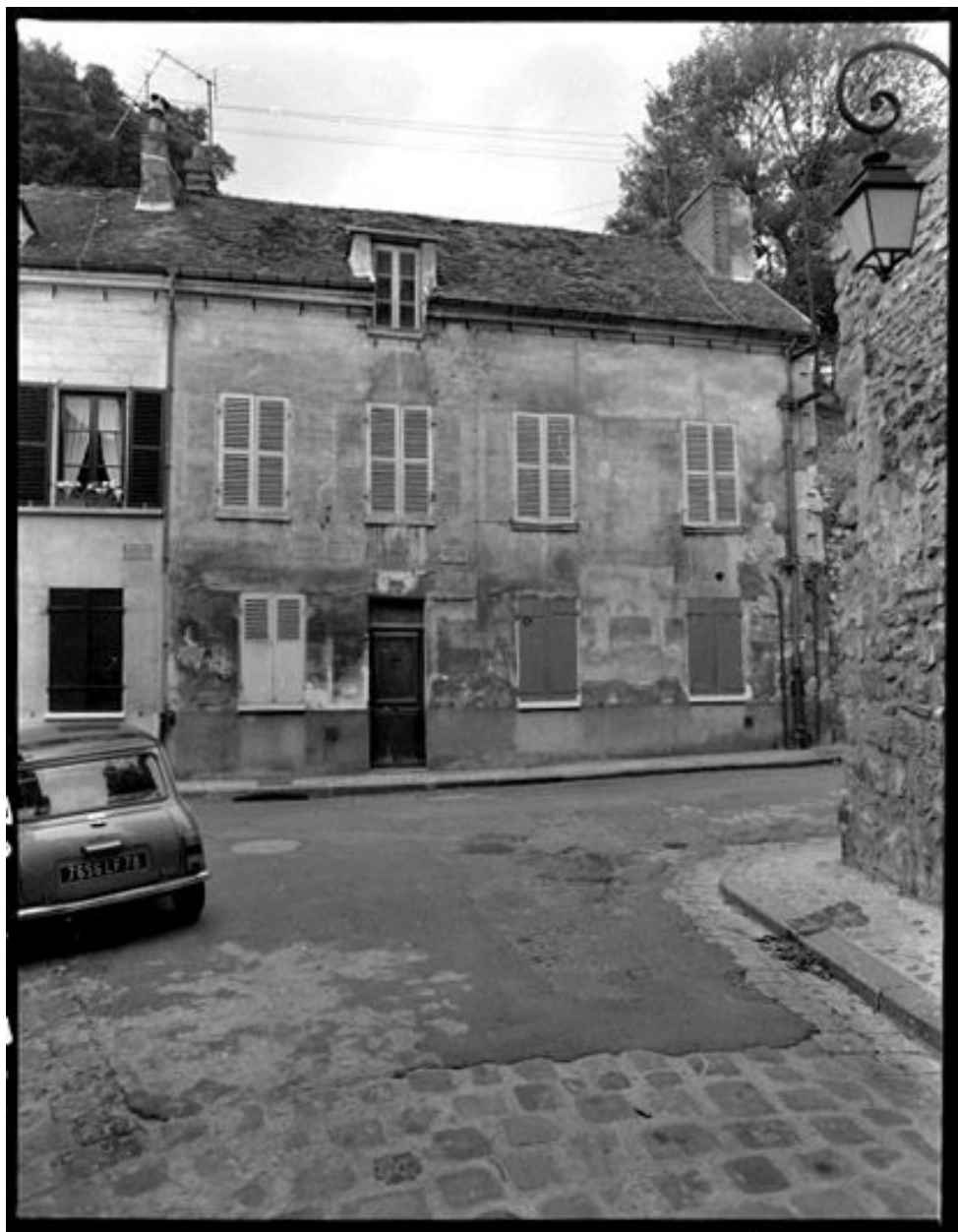
Maison, Fort (rue du) 1. Façade côté Seine.
