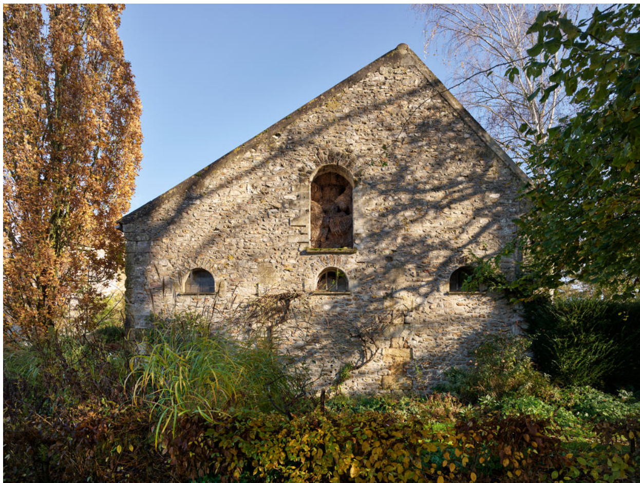
Pignon sud de la dépendance.
