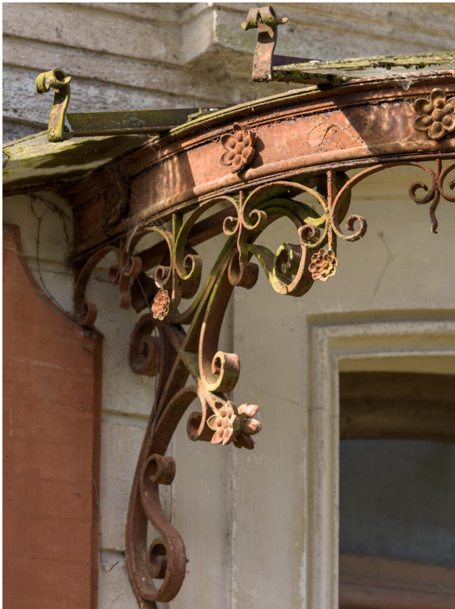
Détail de la marquise.
