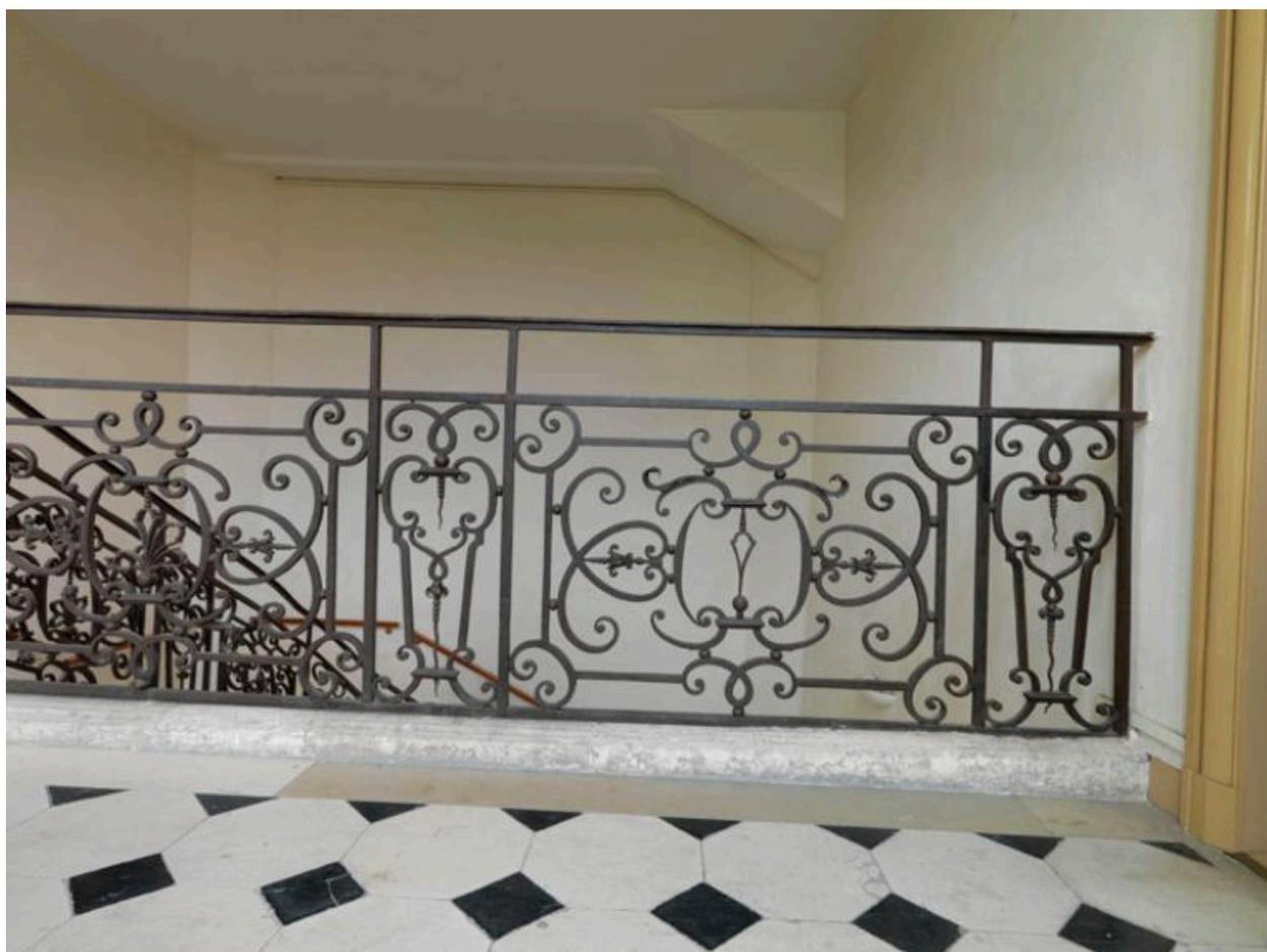
pilastres et panneau rectangulaire de la rampe d'appui.
