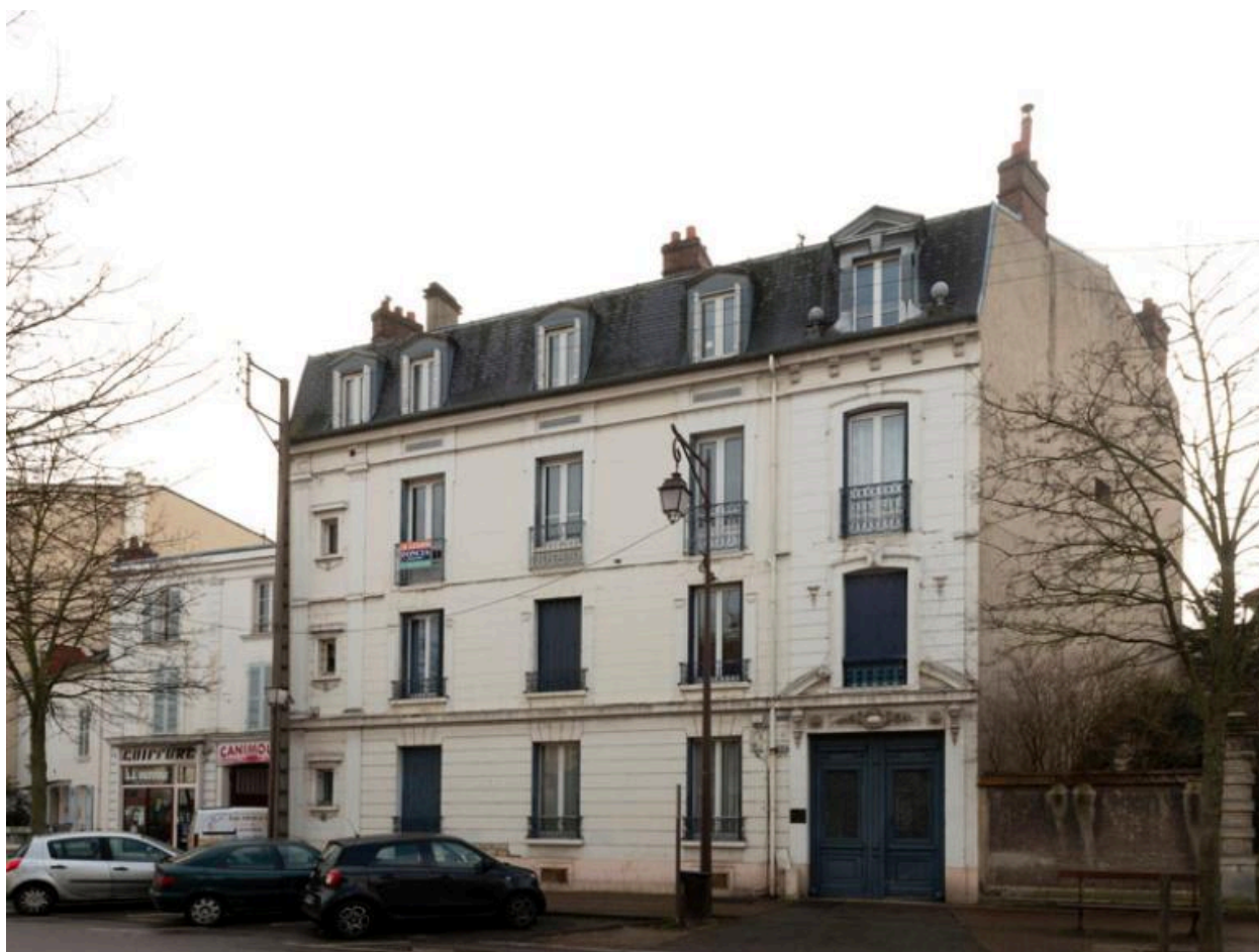
Immeuble aligné, 35, avenue du Président Franklin Roosevelt.
