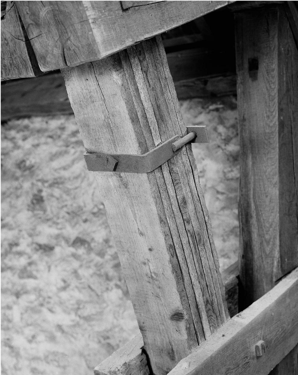
Charpente : détail de l'assemblage des planches formant les poutres par un étrier métallique.
