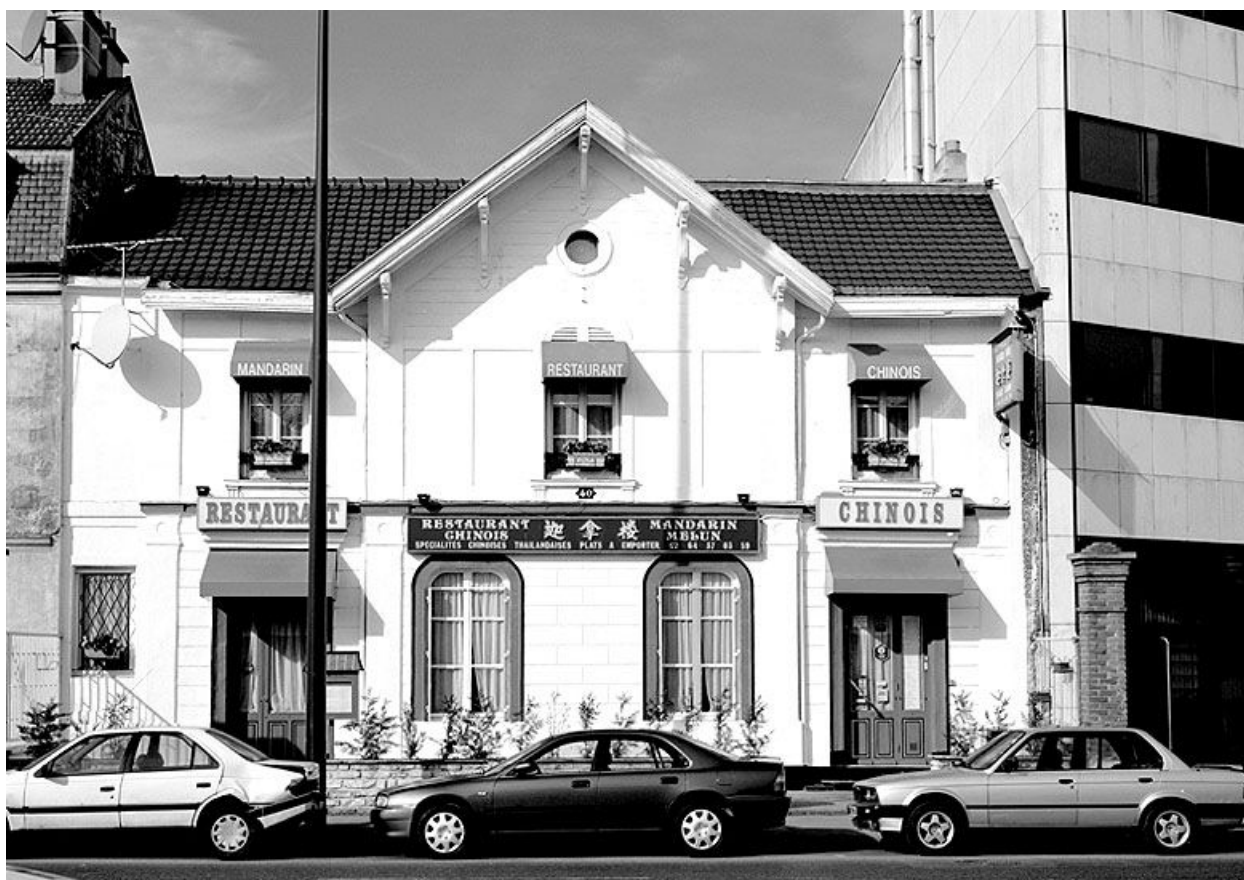
Maison 40, avenue Thiers.
