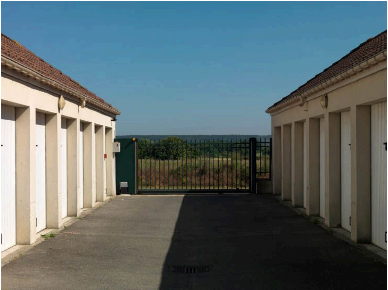
Boissy-sous-Saint-Yon. Résidence de la rue de Châtres.
