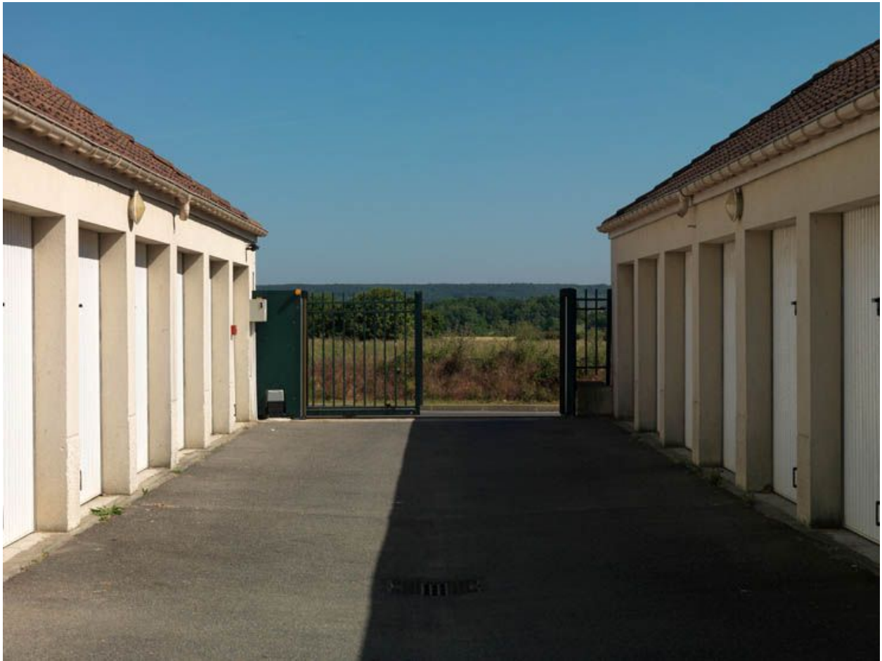
Boissy-sous-Saint-Yon. Résidence de la rue de Châtres.
