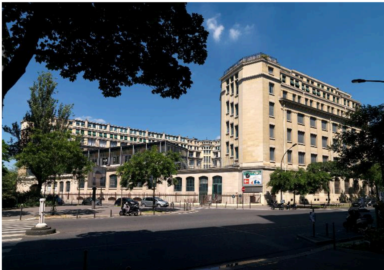
Façade sur la rue Meryon.
