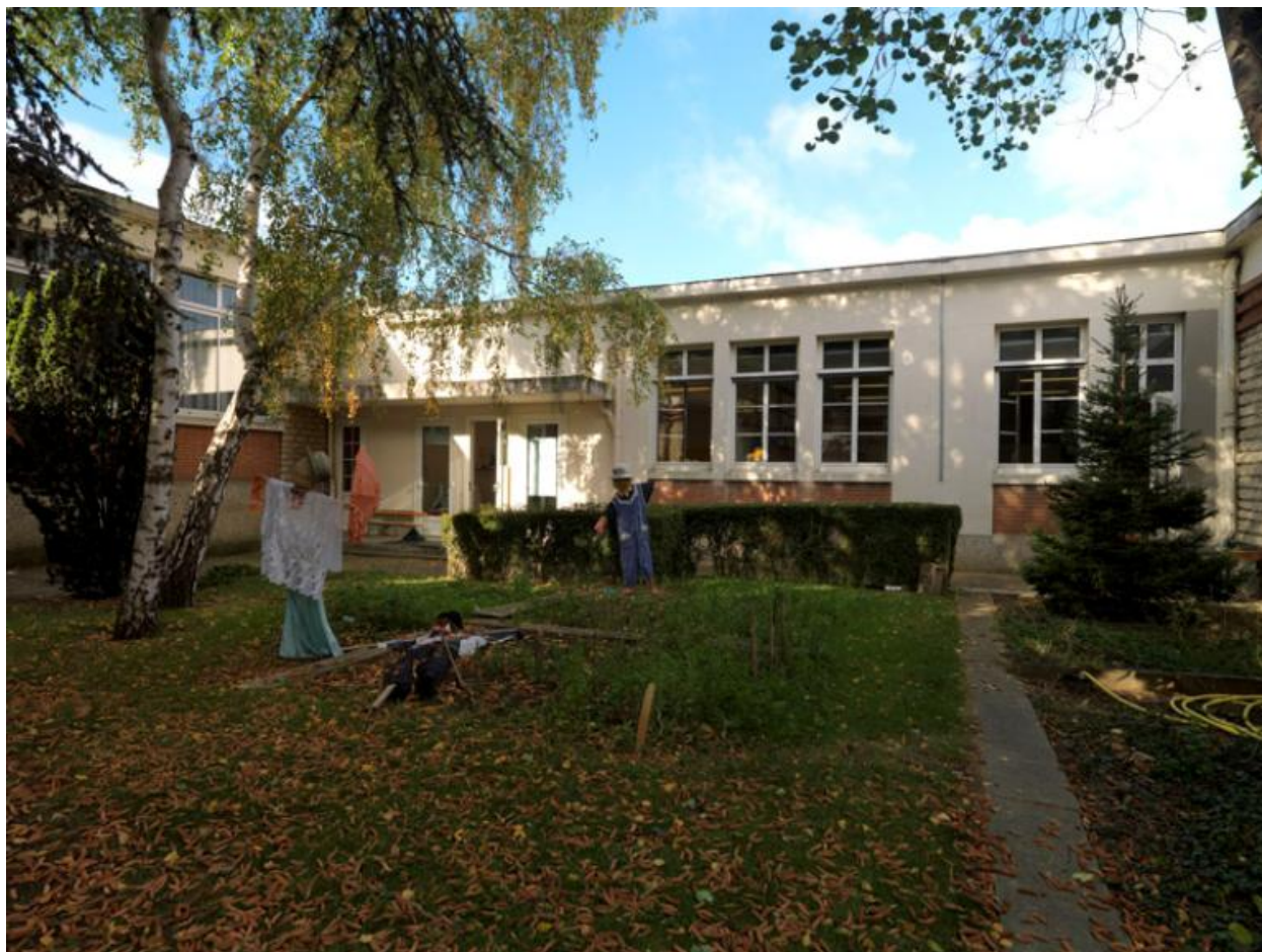
La cour intérieure qui desservait le cinéma scolaire.
