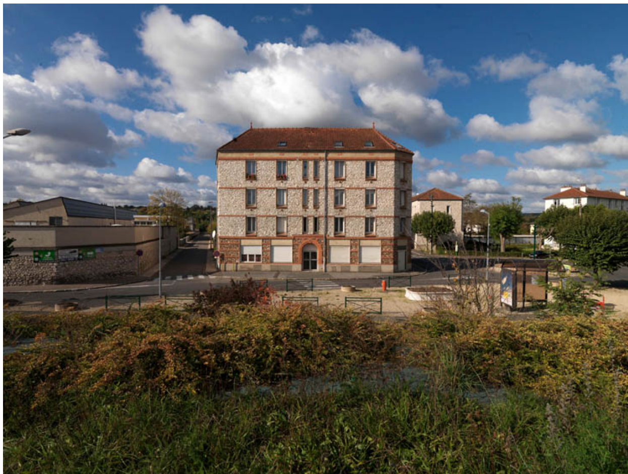
Immeuble 1 place Henri Schneider. Encadrement de porte monumental en briques rouges. Des cordons de briques marquent les niveaux
