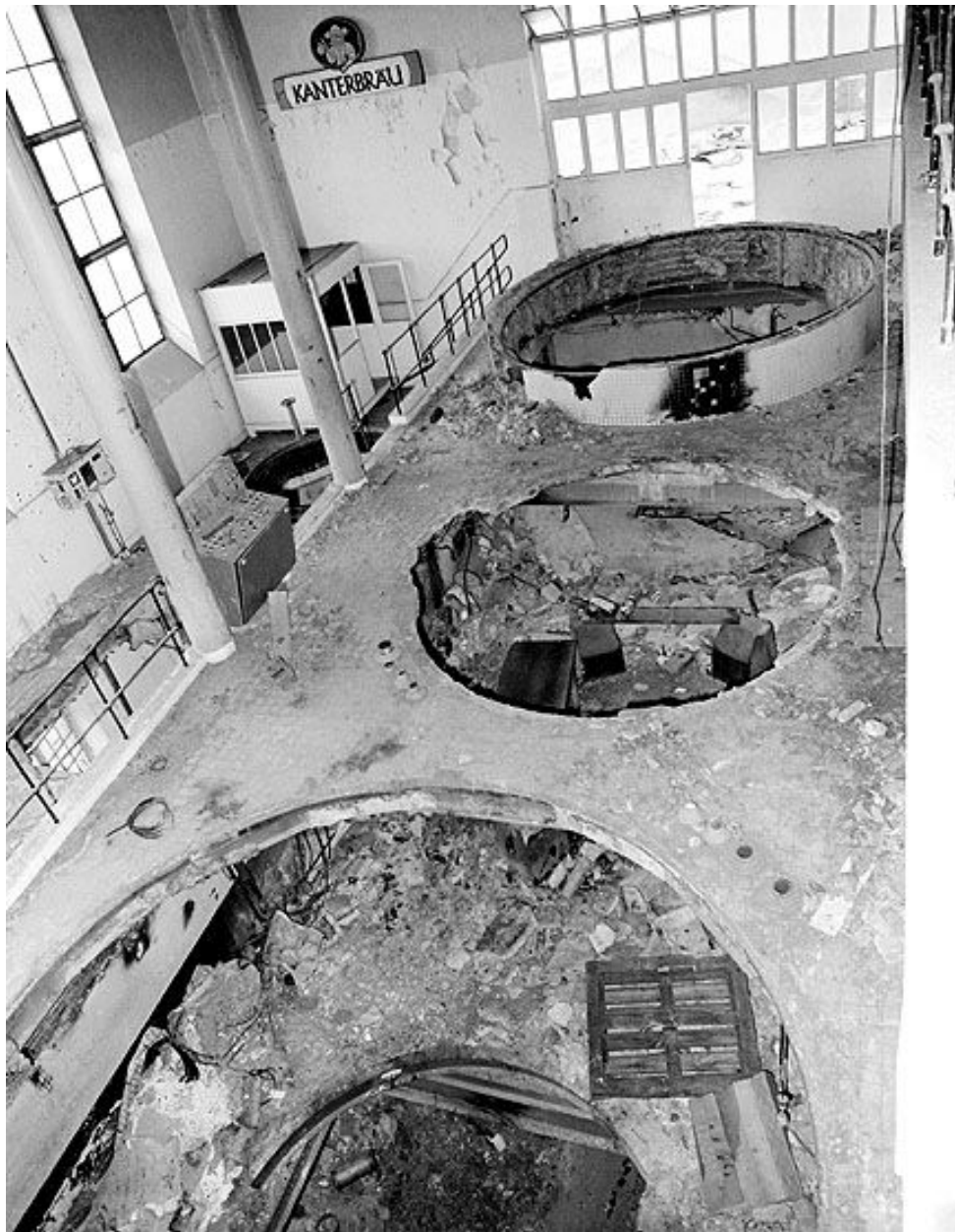
La salle à brasser : emplacement des cuves. Photographie avant destruction, 1989. (Ministère de la culture, Inventaire général. 89SG711X)
