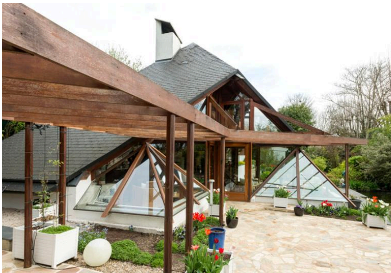
Vue générale de la façade latérale gauche : avancée de la pergola.
