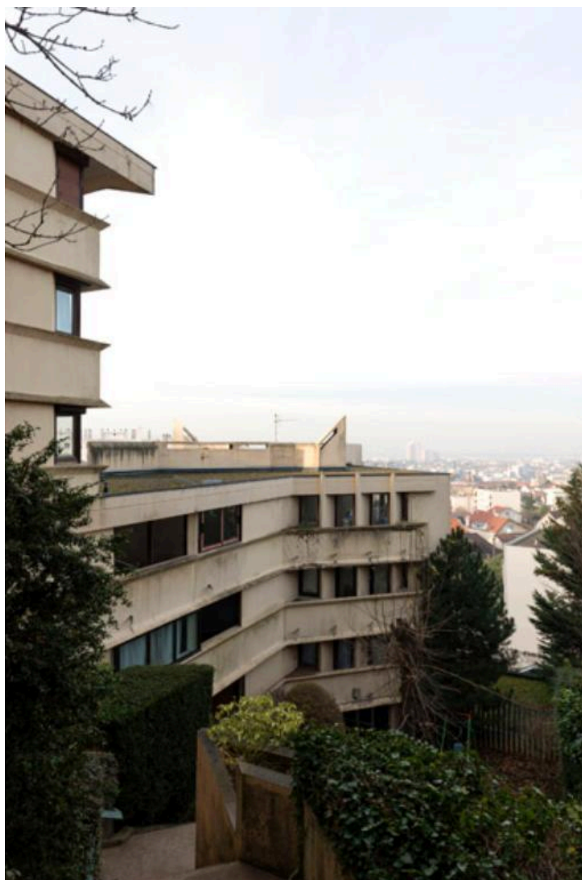
Vue latérale de l'immeuble.
