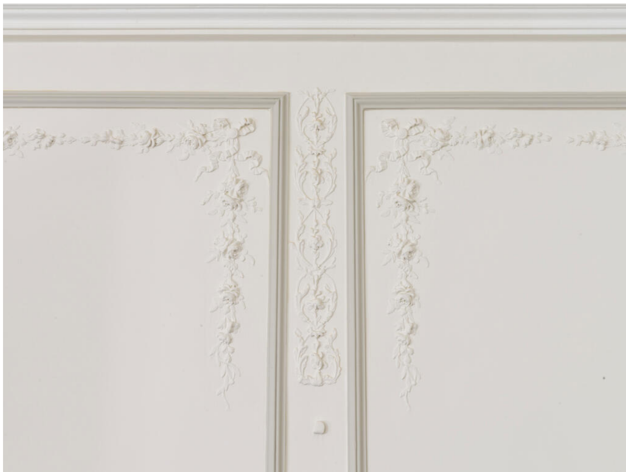
Détail du décor mouluré qui orne les murs de la pièce nord-ouest du rez-de-chaussée.
